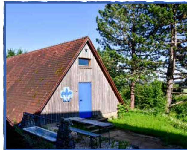
Westansicht Herren-Waschhaus vor der Renovierung
