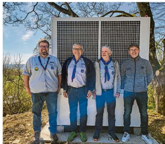
Michael Schofer, Karl Wagner, Martin Bauer und Ingenieur Ralf Büchele freuen sich über die neue Wärmepumpe für das Pfadfinderzentrum Schachen.
