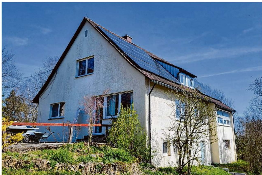
Auf dem Gruppenhaus wurde bereits vor zwei Jahren eine PV-Anlage aufgebracht. Fotos: Maria Bloching
