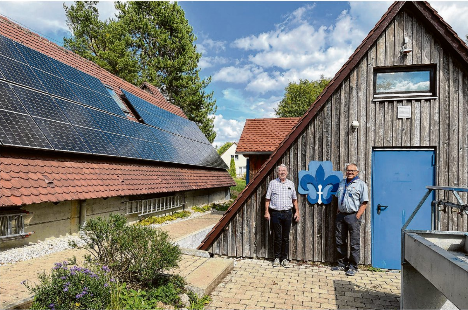
Martin Bauer (links) und Karl Wagner vom VCP Württemberg vor den sanierten Sanitärgebäuden, deren Photovoltaikanlagen inzwischen einen Großteil der Energie liefern. Beide haben den Umbau des Pfadfinderzentrums auf dem Schachen mitgestaltet. Foto: Pia Holzschuh
